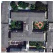
Mái nhà đa hợp
