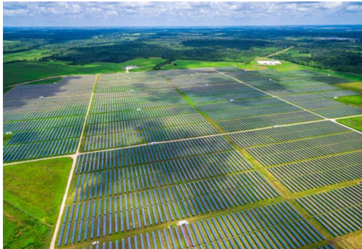
Hình 3.10. Hệ thống điện mặt trời nối lưới quy mô lớn
